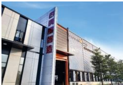
广东东莞混凝土预制构件生产基地
