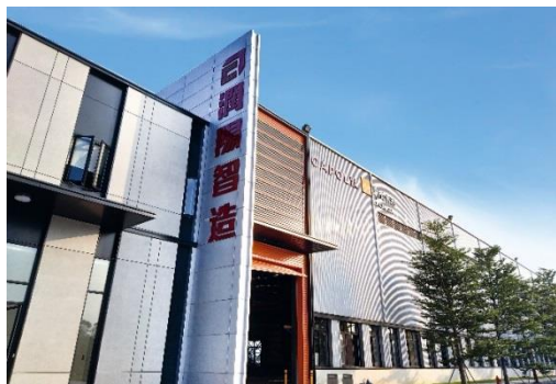
广东东莞混凝土预制构件生产基地
