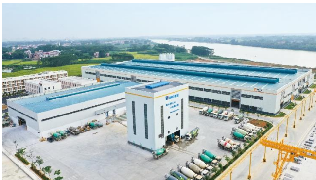
广西贵港装配式建筑工厂
