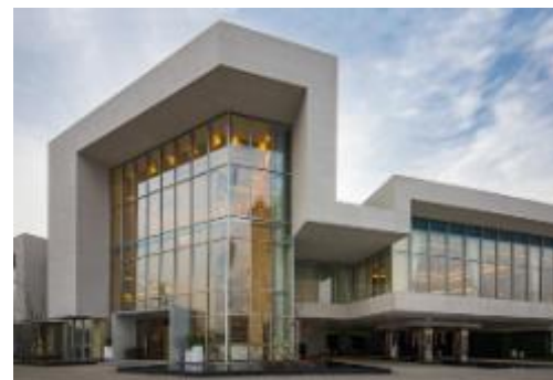
贵阳购物中心的外墙
