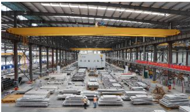
广西贵港混凝土预制构件生产基地
