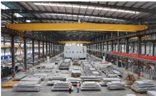
广西贵港混凝土预制构件生产基地
