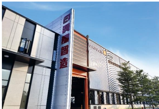
广东东莞混凝土预制构件生产基地
