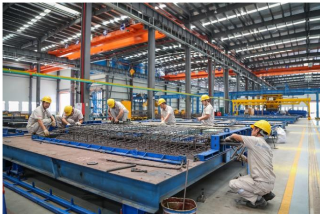
东莞润阳 混凝土预制构件生产线
